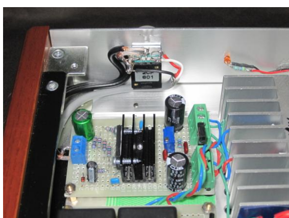
入力ボリューム付近 網のあるシールド線で配線します
